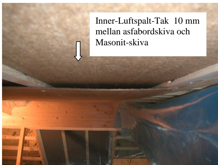
Figur 10. Innerspalt mellan asfaboard och masonitskiva och diffusionsspärr.
