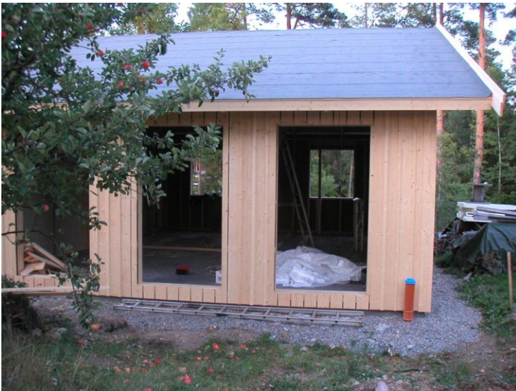
Figur 1. Sydvästsidan på Demo Låg-Exergihus efter stomresningen
