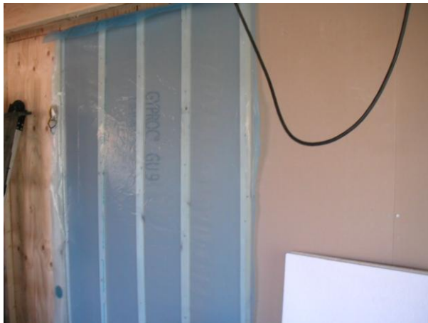
Figur 15 Innerspalt i D-spalt i icke-transparent yttervägg.
